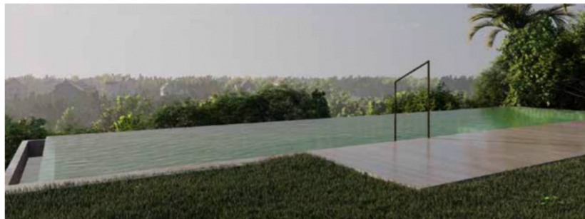
Pileta y SUM en la barranca de San Isidro, Argentina
